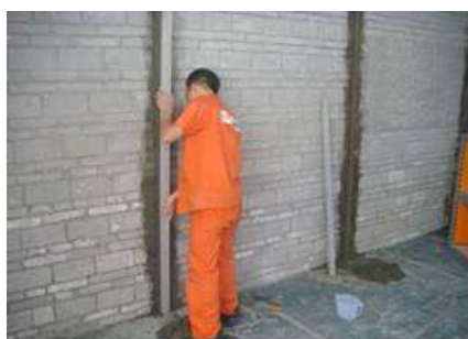
冲筋施工
