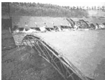
图4 湖南耒阳电厂干煤棚倒塌
