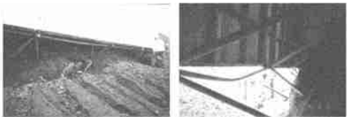
图 2 某电厂干煤棚煤堆挤压和杆件弯曲现象
